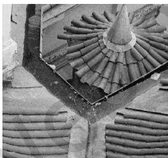
Obr. 10: Při nedostatečné kontrole a údržbě dojde po nějaké době k úplnému ucpání odtokových kotlíků, čímž vznikne v okapních žlabech jakýsi bazén. To může vést jednak k poškození odvodnění, ale i rozvoji hniloby souvisejících konstrukcí, k výskytu řas, mechů a dalším nežádoucím jevům.
