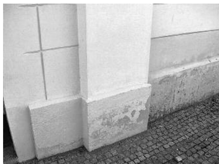
Obr. 2a, b: Zámek Kynžvart. Povrchová úprava soklů z velkoplošných kamenných desek. (Foto R. Gill a autor)
