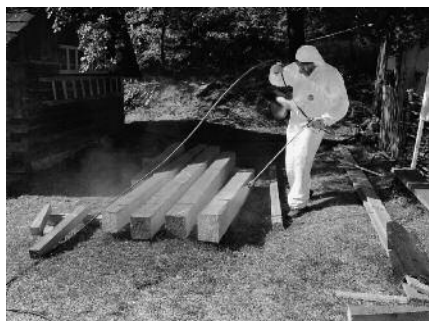
Obr. 12a, b. Vlevo: provedení chemické ochrany (postřik) dřeva, které bude sloužit k výměně poškozených prvků v objektu. Vpravo: postřik prvků nově zabudovaných do konstrukce.
