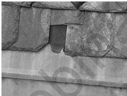
Obr. 6a, b: Praha, Strakova akademie. Vlevo: Ulomená břidlicová deska okapní hrany. Vpravo: Nevhodně provedená oprava hřebíky skrz krytinu.
