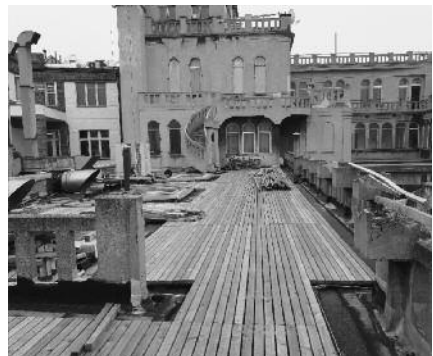
Obr. 1a, b: Palác Lucerna. Vlevo: Odkrývání nepůvodních vrstev živice a mazaniny. Vpravo: Montáž zastíňujících pochozích roštů.
