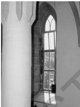
Obr. 3a, b: Vlevo sanktusní věžička s benátskými žaluziemi, vpravo okno s větracím křídélkem.
