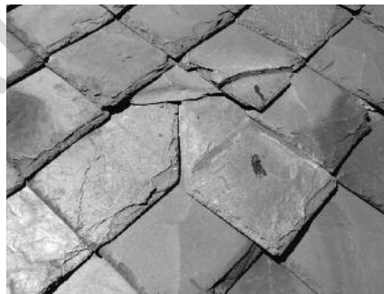
Obr. 6a, b: Praha, Strakova akademie. Vlevo: Ulomená břidlicová deska okapní hrany. Vpravo: Nevhodně provedená oprava hřebíky skrz krytinu.
