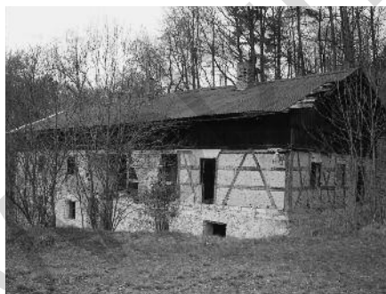
Obr. 3a, b: Mlýn v areálu zámku Kynžvart. Vpravo destrukce spodního trámu nesoucího hrázděnou konstrukci. (Foto autor)
