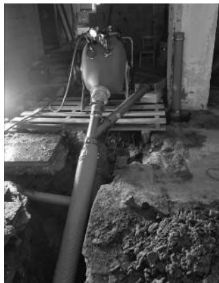
Obr. 8: Vkládání UV inverzního rukávu z tlakového zásobníku do potrubí ve výkopu suterénu, odbočka s motorickou posuvnou jednotkou kabelu UV lamp.
