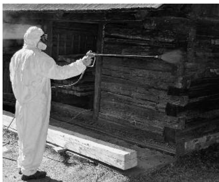
Obr. 10a, b: Preventivní chemická ochrana z vnější strany objektu.
