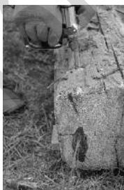
Obr. 13a, b, c: Praktická ukázka chemické tlakové injektáže.
