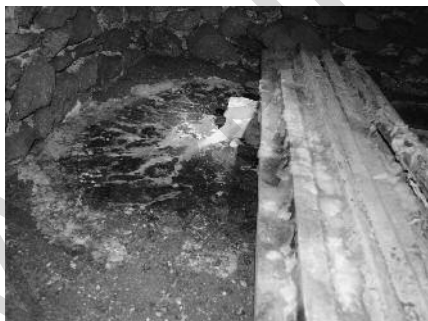
Obr. 11: Ukázka nálezového ložiska dřevomorky domácí ve sklepních prostorách zámku ve Velkých Losínách a její přenesení až do prvků krovové konstrukce při obnově.
