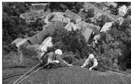
Obr. 5: Hrad Modrý Kameň. Inštalácia dočasných ochranných pletív na korune muriva, ktoré majú zabrániť samovoľnému uvoľňovaniu kameňov. (Foto: Pro Monumenta)
