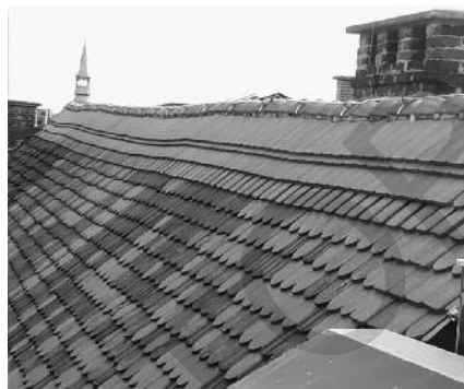
Obr. 2a, b: Graz, Rakousko. Krytina z bobrovky. Vlevo: Barevně pestré plochy střech s postupně vyměňovanými taškami. Vpravo: Detail, hřebenáče do malty a důmyslné větrání hřebene.
