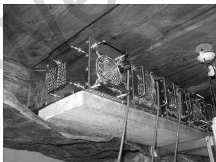
Obr. 14: Ukázka mikrovlnné sanace stropního trámu roubeného objektu.
