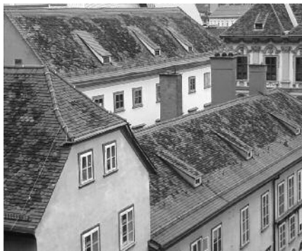
Obr. 2a, b: Graz, Rakousko. Krytina z bobrovky. Vlevo: Barevně pestré plochy střech s postupně vyměňovanými taškami. Vpravo: Detail, hřebenáče do malty a důmyslné větrání hřebene.
