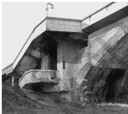
Obr. 4a, b: Libeňský most v Praze. Dlouhodobě zanedbávaná údržba vedla k špatnému technickému stavu mostu. (Foto R. Gill)
