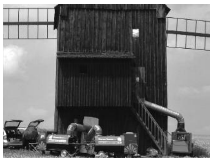
Obr. 15: Ukázka horkovzdušné sanace větrného mlýna u obce Bravinné (okr. Nový Jičín).
