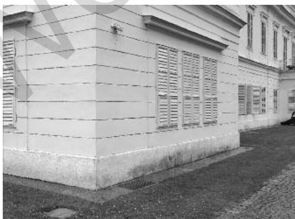
Obr. 2a, b: Zámek Kynžvart. Povrchová úprava soklů z velkoplošných kamenných desek. (Foto R. Gill a autor)
