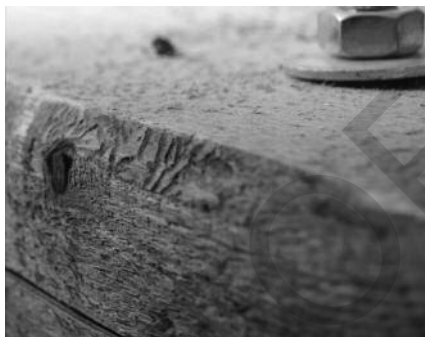
Obr. 6: Detail zbytku kůry s matečnými chodbami po kůrovci.
