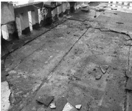
Obr. 1a, b: Palác Lucerna. Vlevo: Odkrývání nepůvodních vrstev živice a mazaniny. Vpravo: Montáž zastíňujících pochozích roštů.
