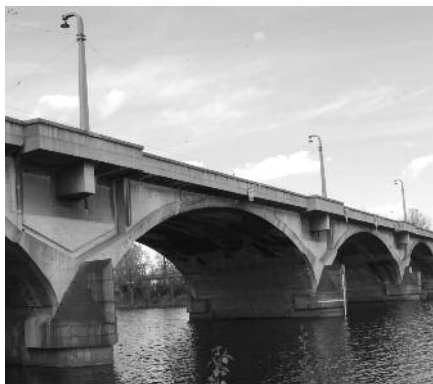
Obr. 4a, b: Libeňský most v Praze. Dlouhodobě zanedbávaná údržba vedla k špatnému technickému stavu mostu. (Foto R. Gill)
