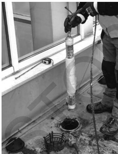
Obr. 4: Oprava dešťového svodu – vkládání krátké sanační vložky.
