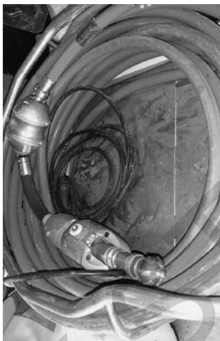
Obr. 1: Vlevo: Roboty pro frézování v potrubí.
