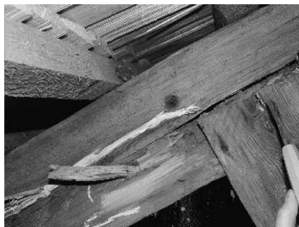
Obr. 11: Ukázka nálezového ložiska dřevomorky domácí ve sklepních prostorách zámku ve Velkých Losínách a její přenesení až do prvků krovové konstrukce při obnově.
