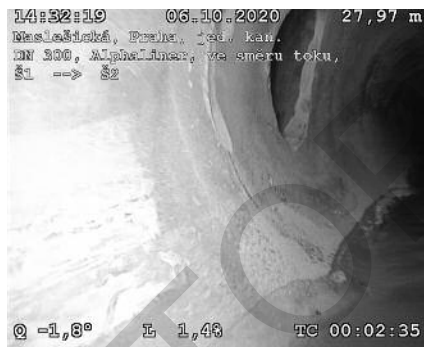
Obr. 6b: Oprava dlouhou sanační vložkou, zatmelený výřez výtoku odbočky.
