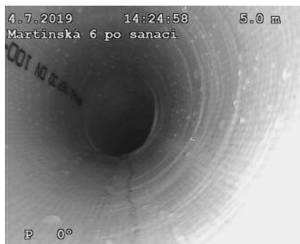
Obr. 7b: Místo netěsného spoje po opravě inverzním rukávem celého úseku (více závad).
