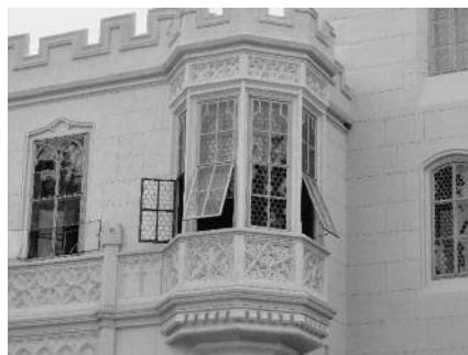
Obr. 5: Zámek Lednice. Okna s ventilačními křídélky.
