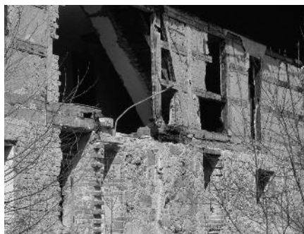
Obr. 3a, b: Mlýn v areálu zámku Kynžvart. Vpravo destrukce spodního trámu nesoucího hrázděnou konstrukci. (Foto autor)
