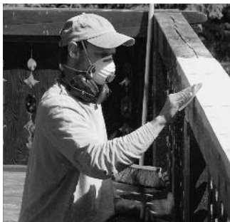
Obr. 7: Tatranská Javorina. Oprava zábradlia poľovníckeho zámčochu Hohenlohe. (Foto: Pro Monumenta)
