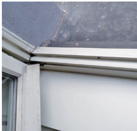
Obr. 15: Spodní upravený práh vnějšího rámu a úprava vnějšího oplechování.
