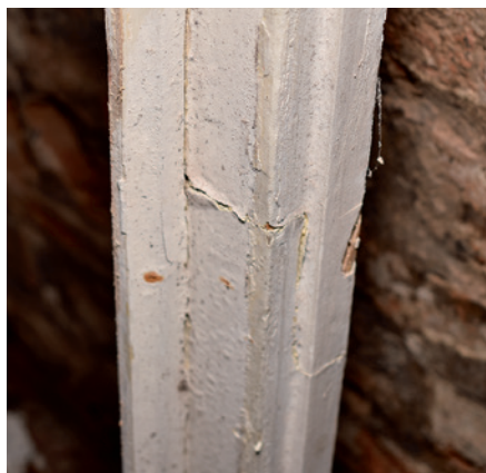
Obr. 4: V rámci oprav oken se vyměňovaly i části svislých vlysů rámu, pohled z lícové strany.
