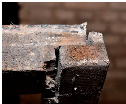
Obr. 3: Spodní vlys je na jedné straně připojen na polodrážku, na obrázku patrně napojení starého a novějšího dřeva.
