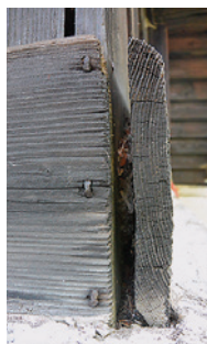
Obr. 4: Pohyb dažďovej vody po svahu a dotovanie podmurovky vlhkosťou.
