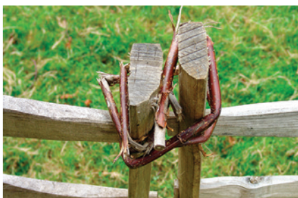
Obr. 8: Pro spojování dřevěných prvků se v minulosti využívaly různé přírodní materiály, které nejenže dobře fungují, ale jsou i vzhledné a lze je snadno opatřit v přírodě. Detail oplocení v parku u paláce Stowe, Anglie. (Foto autor)
