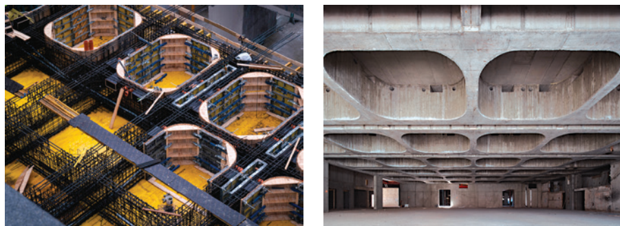
Obr. 6a, b: Rekonstrukce stropní partie velkého sálu z předpjatého pohledového betonu.
