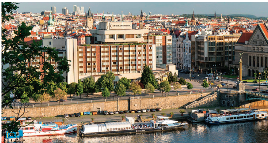
Obr. 1: Pohled na bývalý hotel Intercontinental od severu.
