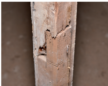
Obr. 5: Tentýž detail, pohled z rubové strany. Je patrné, že vlys byl uřezán v místě napadeném dřívě hnilobou.
