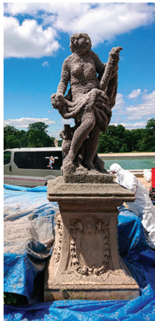
Obr. 3: Slavkov u Brna – odsolování soch materiálem SALISORB.
