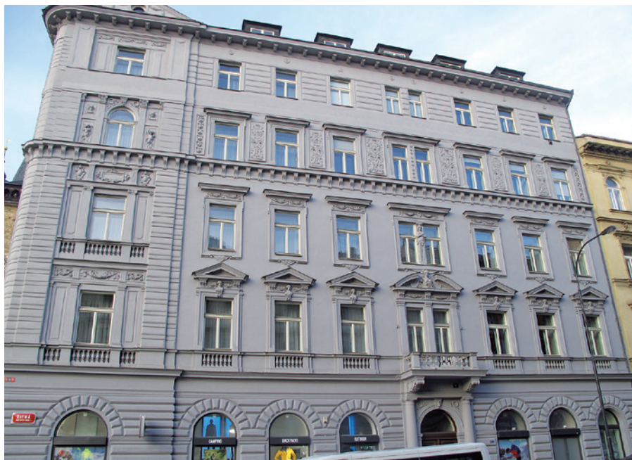
Obr. 1: Žitná ul. čp. 669, Praha 1. Pohled na průčelí do Žitné ulice po realizaci úprav špaletových oken a opravě fasády.
