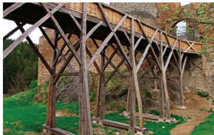
Obr. 11: Ze dřeva lze zhotovovat i konstrukčně velmi odvážné stavby – oproti oceli má dřevo výhodu menší vlastní váhy při obdobné nosnosti. Dřevěný most přes příkop u hradu Krakovec. Konstrukční řešení Ing. V. Mlázovský, realizace P. Růžička. (Foto autor)
