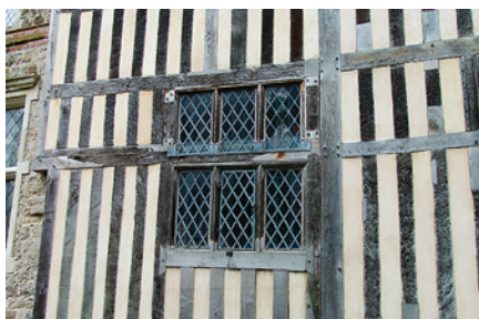
Obr. 7: Dřevo bylo v minulosti úspěšně kombinováno s jinými přírodními stavebními materiály – zejména s cihelným zdivem. Tzv. hrázděné konstrukce představují skvělý, velmi staticky odolný konstrukční systém. Ightham Mote, Anglie, detail průčelí. (Foto autor)
