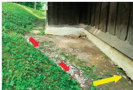
Obr. 4: Pohyb dažďovej vody po svahu a dotovanie podmurovky vlhkosťou.
