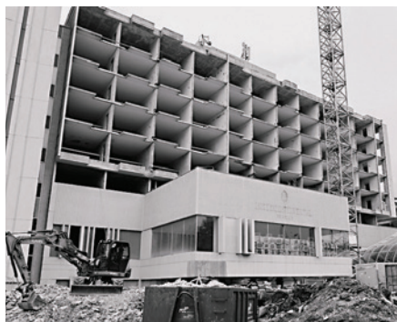
Obr. 4a, b: Fasáda před rekonstrukcí a po odstojení na železobetonové jádro.
