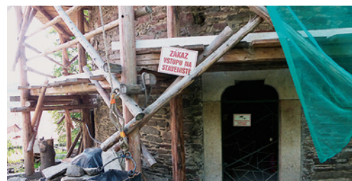
Obr. 3: Vedle stavebních konstrukcí (např. hrázdné zdivo, krov, podlahy, stropy) dřevo bylo a někde je stále vynikajícím materiálem při stavbě lešení, podpůrných konstrukcí, výdřev atd. Na snímku detail štenýřového lešení postaveného v rámci opravy věže hradu Rožmberk (konstrukce, stavba – Ing. V. Mlázovský, P. Růžicka). (Foto autor)
