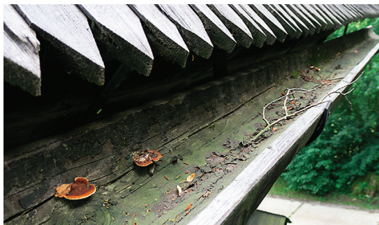
Obr. 13: Degradácia dreveného odkvapového žlabu – plodnice trámky plotovej sú indikátorom výrazného poškodenia dreva (pri výskyte plodnice trámky na povrchu dreva je už zvyčajne vnútorná časť prierezu dreva silno poškodená mycéliom huby).
