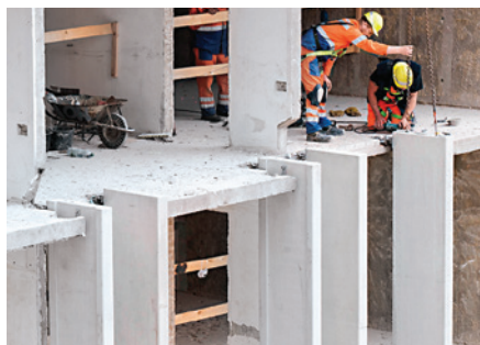
Obr. 9a, b: Přesná montáž nových prefa panelů („žiletek“) na zámky s přerušenými tepelnými mosty.
