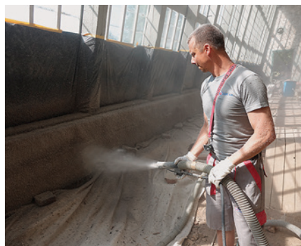
Obr. 1a, b: Strojní nanášení buničiny SALISORB je vhodné na velkých soudržných plochách.
