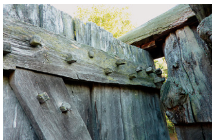
Obr. 13: Velkou předností dřeva je schopnost přirozeně stárnout, což se týká zejména tvrdých dřevin. Hrubě sesazené dveře bez hřebíků či šroubů v areálu skanzenu Doppeldorf, Německo. (Foto autor)
