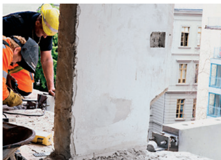
Obr. 9a, b: Přesná montáž nových prefa panelů („žiletek“) na zámky s přerušenými tepelnými mosty.
