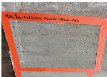
Obr. 7: Zkouška lazurního nátěru na historickém monolitu, vzorek č. 32.
