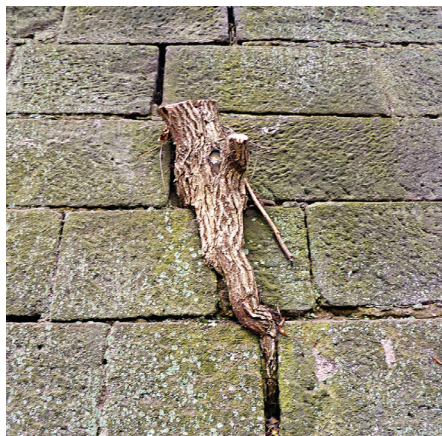
Obr. 5: Při hledání příčiny vlhnutí staveb je vždy nutné vyhodnotit nejen vlastní objekt, ale i jeho okolí. Velmi důležité jsou změny v okolním terénu, ať ve smyslu snížení nebo zvýšení. Speciálně je třeba sledovat různé „haldy“ či přisýpaný materiál, vyvezenou suť apod. Jde často nejen o zdroj vlhnutí, ale i vodorozpustných solí, které ještě zvyšují zátěž budov.
