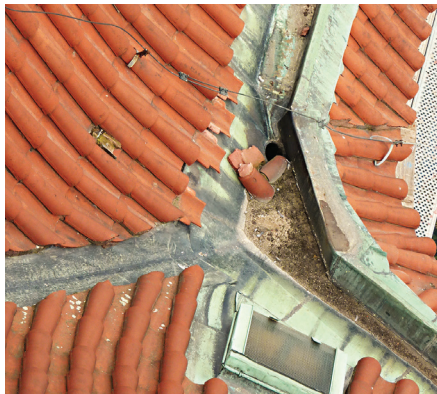
Obr. 10: Při nedostatečné kontrole a údržbě dojde po nějaké době k úplnému ucpání odtokových kotelníků, čímž vznikne v okapních žlabech jakýsi bazén. To může vést jednak k poškození odvodnění, ale i rozvoji hniloby souvisejících konstrukcí, k výskytu řas, mechů a dalším nežádoucím jevům.
