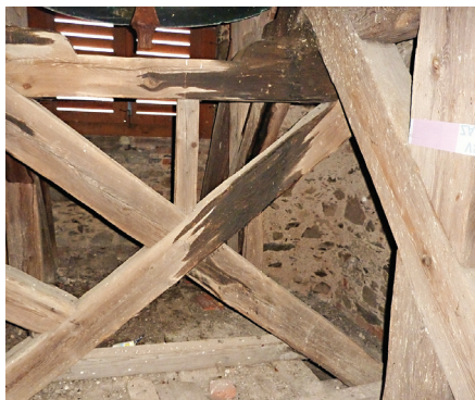
Obr. 7: Stav krovů a obecně dřevěných konstrukcí v objektu je nutno průběžně kontrolovat. Jasným signálem, že něco není v pořádku, jsou tmavá zvlhlá místa na trámech, skvrny na podlaze, charakteristický zápach. Trámy, které jsou napadeny houbou nebo hmyzem, mohou být na povrchu celistvé, ale při poklepu budou znít dutě, případně do nich snadno vnikne ostrý nějakého nástroje (sekerka, nůž).
