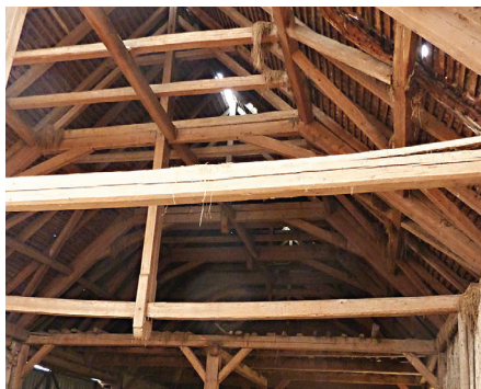
Obr. 8: Řada konstrukcí v krovu, kde je problém, může mít zdeformovaný tvar, a to buď průhybem, natočením, výskytem trhlin. Zdravá konstrukce (např. trámy v podlaze) by měla lehce pružit při došlapu. Je vhodné také prověřit detaily tesařských spojů, např. zda nejsou posunuty, natočeny či nepraskají.
