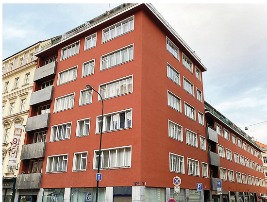
Obr. 1: Při obnově fasády v Příčné ulici čp. 668 v Praze 1 bylo respektováno barevné řešení architekta Kotase ověřené četnými sondami. Povrch omítek byl opatřen silikátovou barvou sytě červeného odstínu. [1]
