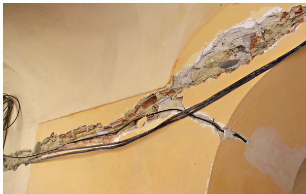
Obr. 12: Při provádění stavebních úprav je třeba dohlížet na to, zda nejsou prováděny stavební zásahy ohrožující statiku kleneb, klenebních pasů apod. Je třeba zejména kontrolovat trasování inženýrských sítí, a to jak ve výkresech, tak vlastní provádění na stavbě.
