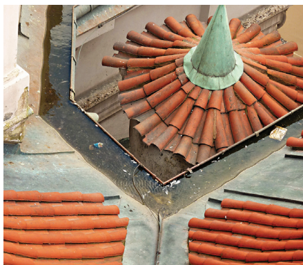
Obr. 10: Při nedostatečné kontrole a údržbě dojde po nějaké době k úplnému ucpání odtokových kotelníků, čímž vznikne v okapních žlabech jakýsi bazén. To může vést jednak k poškození odvodnění, ale i rozvoji hniloby souvisejících konstrukcí, k výskytu řas, mechů a dalším nežádoucím jevům.
