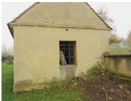
Obr. 5: Při hledání příčiny vlhnutí staveb je vždy nutné vyhodnotit nejen vlastní objekt, ale i jeho okolí. Velmi důležité jsou změny v okolním terénu, ať ve smyslu snížení nebo zvýšení. Speciálně je třeba sledovat různé „haldy“ či přisýpaný materiál, vyvezenou suť apod. Jde často nejen o zdroj vlhnutí, ale i vodorozpustných solí, které ještě zvyšují zátěž budov.
