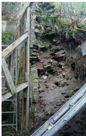
Obr. 19: Struktura dlouhodobě vodou vyplávaného šibovaného kamenného zdiva.
