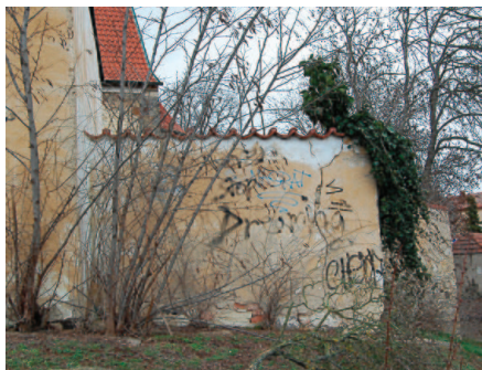
Obr. 10: Roztržení zdiva v nároží od prorůstání náletové zeleně.
