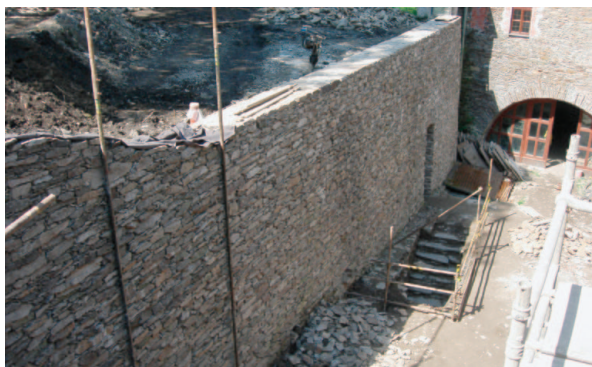
Obr. 20: Detail provizorního zajištění svahu během stavebních prací (tyčové kotvy).
