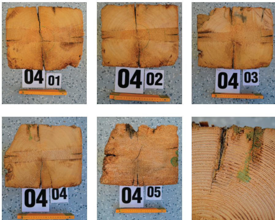
Obr. 7b: Dokumentace průniku chemické látky po tlakové injektáži na trámu č. 4 – jednotlivé výřezy (Thermo Sanace s.r.o.).
