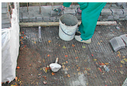
Obr. 7, 8: Geomříže jsou kotveny do zdiva z betonových cihel (0,3m tlusté) pomocí ocelových trnů. Vlastní zásypy jsou provedeny z drceného kameniva frakce 16/32mm.
