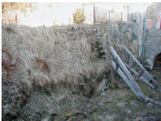
Obr. 18: Pohled na zřícenou část dlouhodobě neudržované opěrné zdi dvora.
