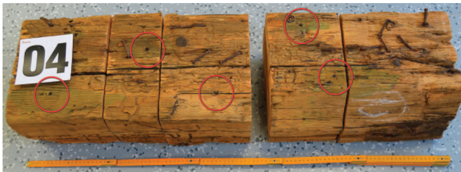
Obr. 7a: Dokumentace průniku chemické látky po tlakové injektáži na trámu č. 4 – celkový pohled (Thermo Sanace s.r.o.).
