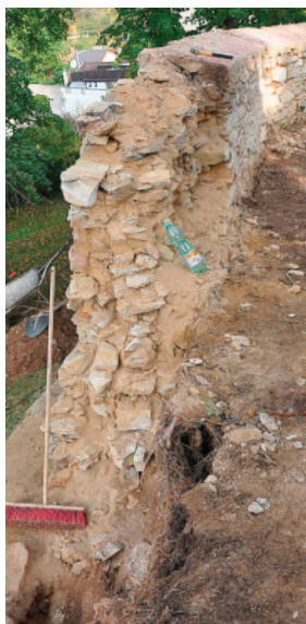
Obr. 14: Skutečná vazba a kvalita původně uvažované ponechávané východní části zdi.
