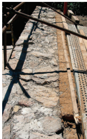
Obr. 21: Detail jílové izolace na rubu stěny.
