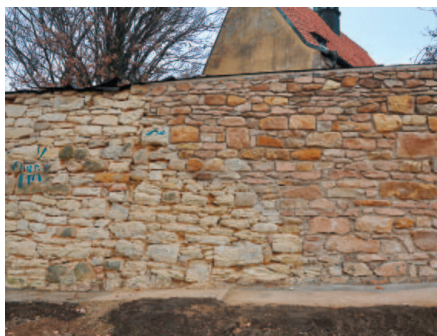
Obr. 16: Napojení nově vyzdžené části zdiva na ponechávanou část.
