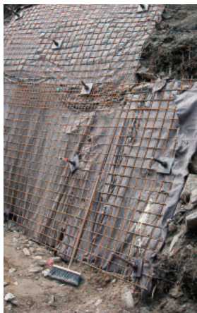
Obr. 20: Detail provizorního zajištění svahu během stavebních prací (tyčové kotvy).
