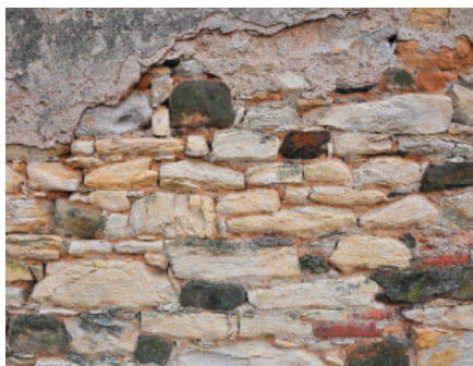
Obr. 17: Problematická kvalita povrchu kamene ponechaného zdiva jako podkladu pro novou omítku.
