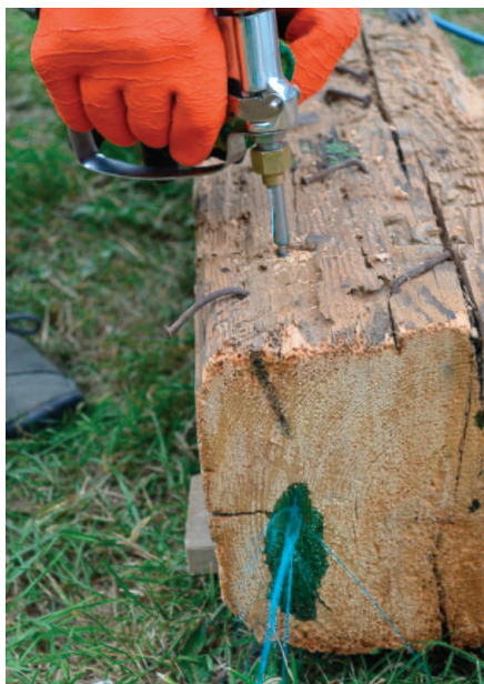
Obr. 2: Fotodokumentace realizace tlakové injektáže a schéma systému rozmístění vstupů pro injektování (Thermo Sanace s.r.o.).
