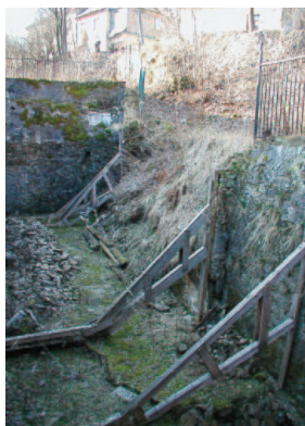
Obr. 18: Pohled na zřícenou část dlouhodobě neudržované opěrné zdi dvora.
