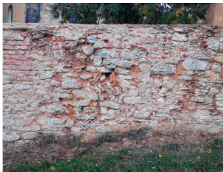
Obr. 13: Skutečné provedení a vazba zdiva na povrchu ponechané části zdi po osekání omítky.
