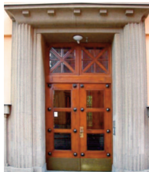
Obr. 2: Umělý kámen na portálu vstupních dveří.
