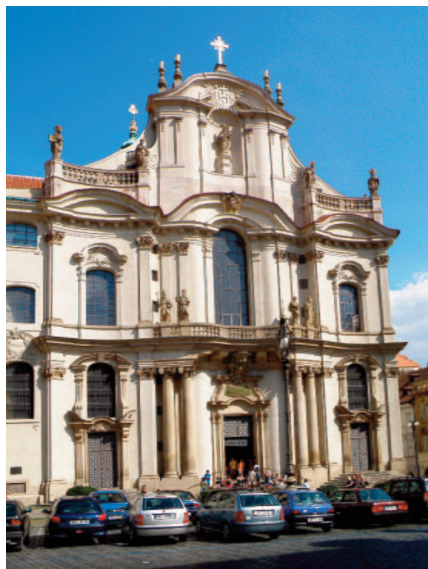
Obr. 2: Chrám sv. Mikuláše na Malé Straně. Příklad úspěšného restaurování nenatíraných pohledových omítek vápennými technologiemi.
