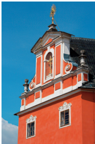
Obr. 8, 9: Broumovský klášter – historická brána a průčelí jižního křídla prelatury. Příklady úspěšné obnovy vápenným nátěrem.
