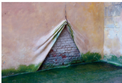
Obr. 1: Umělecké dílo na dvorku Domu U rytířů, Školská 693/28, Praha 1 – Nové Město, chce primárně pobavit. Můžeme mu ale přisoudit i funkci reklamy na šetrné chování k historickým omítkám. Proč je otloukat, když to jde i jinak?
