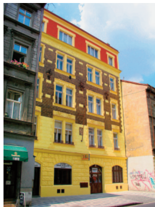
Obr. 10: Jesenice, areál fary, obr. 11: Smíchov, činžovní dům. Není žlutá jako žlutá. Rozdíl mezi použitím historicky adekvátního a neadekvátního materiálu fasádního nátěru.
