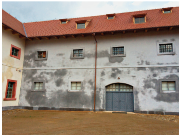
Obr. 6. Projev přítomnosti hygroskopických solí v omítce. Hospodářský dvůr v Plasích.
