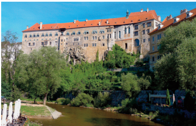
Obr. 7: Obnova jižního průčelí Horního hradu v Českém Krumlově získala v roce 2008 Cenu Europa Nostra. Příklad úspěšné konzervace dochované podoby průčelí, které sice není ruinou, ale je do té míry nepřístupné, že zde cyklus pravidelných obnov po staletí neprobíhal.
