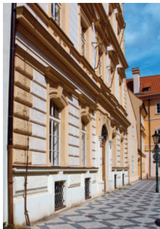
Obr. 4 (vlevo): Praha 1 – Malá Strana, Maltézské náměstí 472/16. Příklad zmrzačení architektonického řešení fasády řešením barevnosti. Průčelí je komponováno jako monochromní, použití dvou odstínů je proto nevhodné. Barevné vytržení průběžné podokenní římsy přízemí, soklu a stojek portálu z logiky užitého tvarosloví je chyba.
