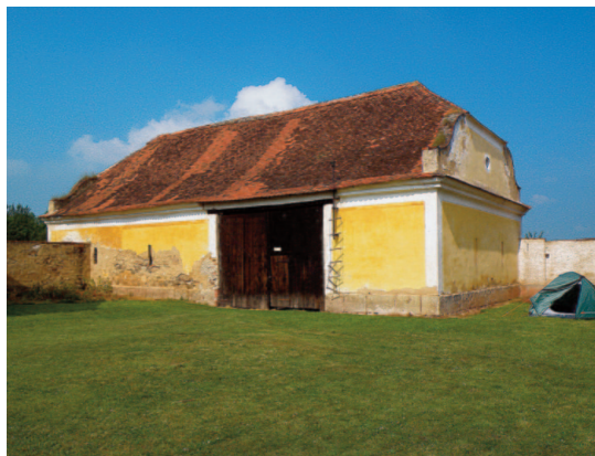
Obr. 10: Jesenice, areál fary, obr. 11: Smíchov, činžovní dům. Není žlutá jako žlutá. Rozdíl mezi použitím historicky adekvátního a neadekvátního materiálu fasádního nátěru.
