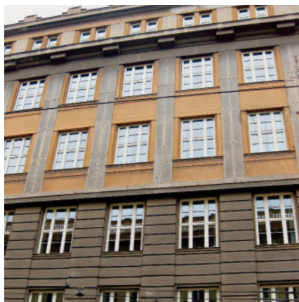
Obr. 4c: Zemský dům – současný stav. Detail fasády do Žerotínova nám.
