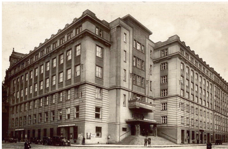
Obr. 4a: Zemský dům III – část umístěná na Žerotínově náměstí 1. (Foto: K. Náhůnek, 1925)
