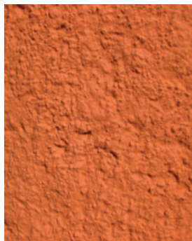
Obr. 3b: Detail natřené šlechtěné omítky.
