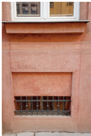
Obr. 11: Oprava umělého kamene v soklové části bytového domu.
