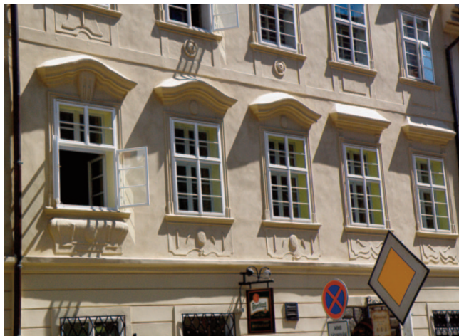
Obr. 3: Praha 1 – Malá Strana, Tomášská 25/6. Příklad úspěšné obnovy vápenným nátěrem s respektováním historického řešení odvodnění nadokenních říms.
