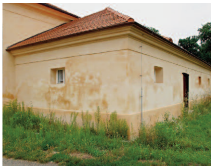
Obr. 4: Uliční část hospodářského křídla. (Foto R. Gill, 2016)
