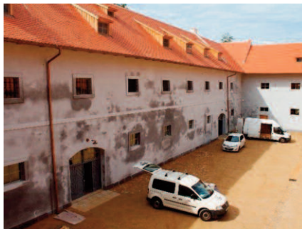
Obr. 7: Stav objektu D po obnově v roce 2015. (Foto P. Rovnaníková)
