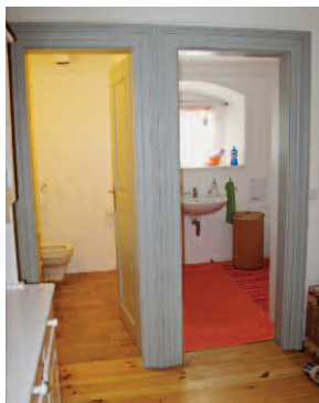
Obr. 7: Stěny hospodářského křídla v koupelně a WC opatřené omyvatelnými nátěry. (Foto R. Gill, 2016)
