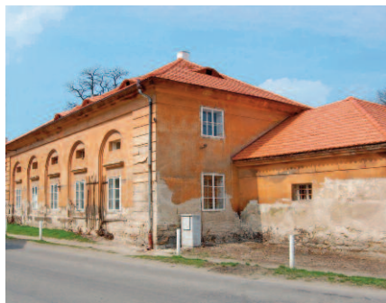
Obr. 1: Pohled na jižní průčelí Domu lesního při zahájení rekonstrukce. (Archiv správy zámku)
