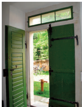
Obr. 8: Původní ventilační prvek (zde okno nadsvětlíku) osazen napevno. Z bezpečnostních důvodů jej nelze využívat. (Foto R. Gill, 2016)
