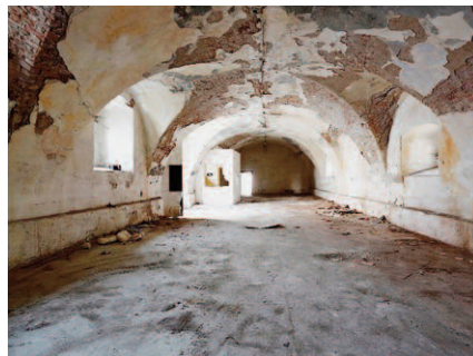
Obr. 9: Stav přednáškového sálu před obnovou. (Foto P. Kodera)
