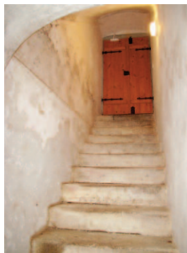
Obr. 6: Stav povrchů v suterénu. (Foto R. Gill, 2016)
