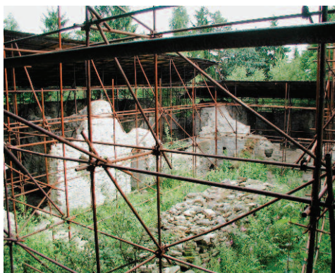
Obr. 5: Část provizorního zastřešení hradu Vizmburk.
