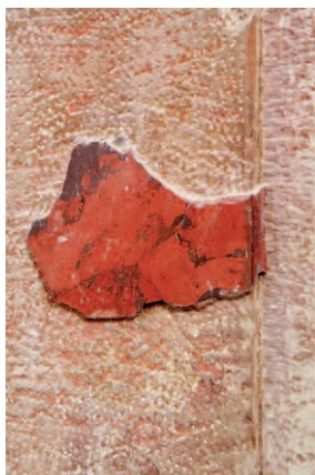
Obr. 3a, b: Potažení umělým mramorem patří k těm výtvarně náročnějším krycím povrchovým úpravám kamene, v tomto případě pískovce. Litomyšl, piaristický kostel Nalezení svatého Kříže – portál sakristie, celek a detail. (Foto autor)
