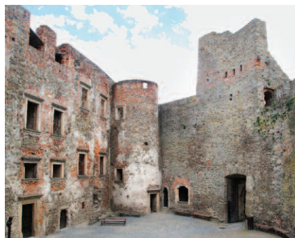
Obr. 3: Dto, 06/2016 [2]. Zřejmý úbytek původních omítek.
