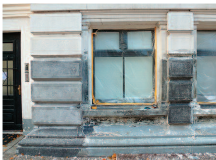
Obr. 17: Velvyslanectví ČR v Haagu – fasáda, přízemí.
