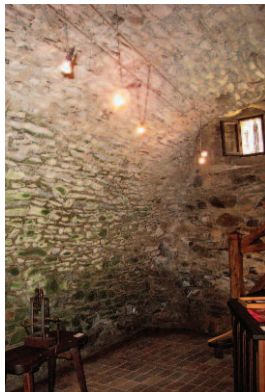
Obr. 7, 8. Vlevo: Vnitřní část paláce. Betonový povrch zadržuje vodu. Ta prosakuje do suterénu spárou mezi asfaltovou izolací a původním zdivem. Vpravo: Suterén paláce. Koroze zdiva poškozovaného opakovaným zatékáním vody. O trvale vlhkém prostředí svědčí výskyt zelené řasy. 06/2016 [2].
