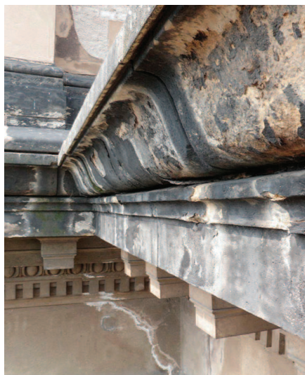
Obr. 1: Národní muzeum v Praze, zatékání do římsy (2013).
