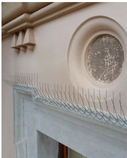
Obr. 4: Praha – Černínský palác, doplněný maltový klín na horní hraně šambrány (2011).
