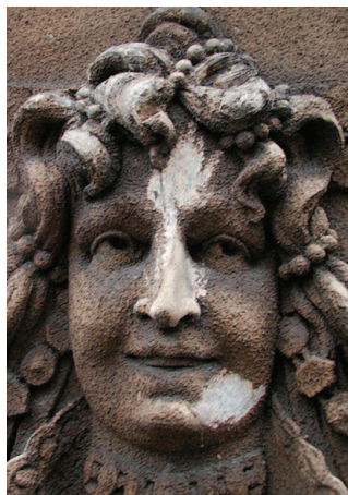
Obr. 3: Novodobé strukturní nátěry potlačují plasticitu štukových prvků.
