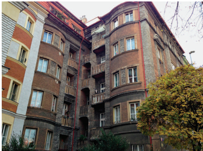
Obr. 2: Promyšlenou kombinací materiálů lze dosáhnout delší životnosti. Omítky z hydraulického vápna byly probarveny ve hmotě antukou. Poškození je jen lokální, fasáda je hlavně zašpiněná.
