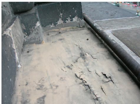
Obr. 5: Stará stěrka na římse Národního muzea v Praze.
