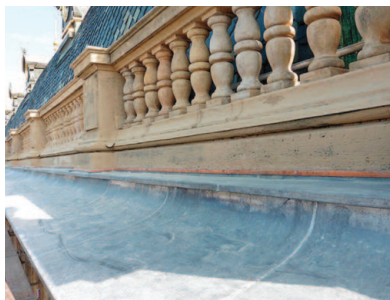
Obr. 10: Praha – Národní divadlo, krytí korunní římsy a trnože balustrády olovem (2015).
