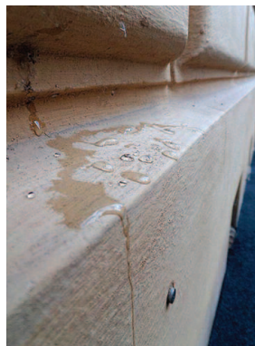
Obr. 7: Nátěr s hydrofobizací (foto J. Bárta).
