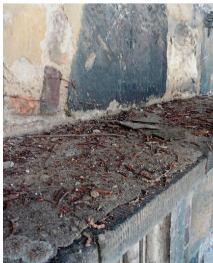
Obr. 3: Pražský hrad – Ludvíkovo křídlo, krytí parapetní římsy epoxidovou maltou, 70. léta 20. stol. (2015).
