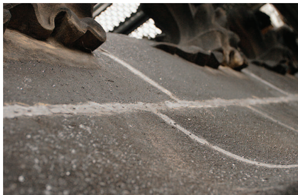
Obr. 6: Hydrofobizace kamene na chrámu sv. Víta (foto P. Měchura).
