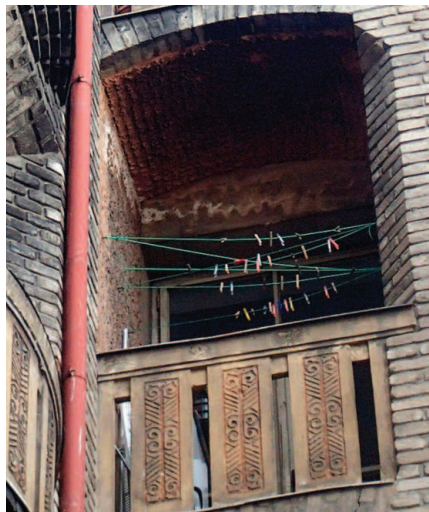
Obr. 5: Souvislý pás výkvětů na omítkách pod stropem lodžie. Souvisí s hnízděním holubů, na fasádu zatéká srážková voda kontaminovaná holubiími exkrementy.
