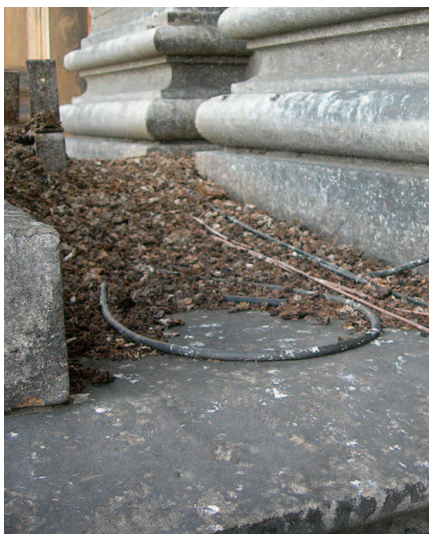
Obr. 2: Národní muzeum v Praze, biologické znečištění u paty sloupů loggie (2013).
