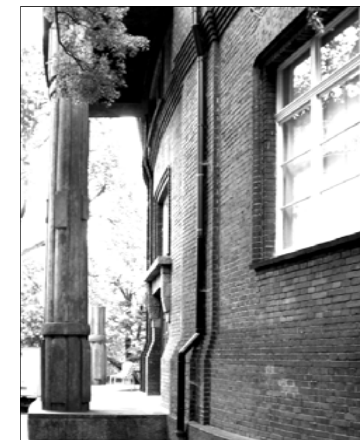
Rezné zdivo fasády Bílkovy villy v Praze
