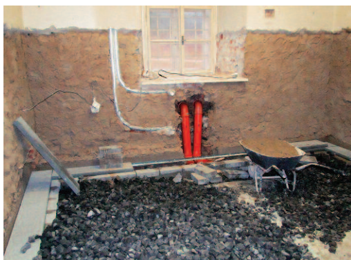
Obr. 10: Ke snížení vlhkosti zdiva přízemí byly využity zděné větrací kanály s nádechy pod parapety oken a odtahem do komínů. Původní povrchy byly odsoleny pomocí absorbentů solí (foto Jan Dohnal, 2015).
