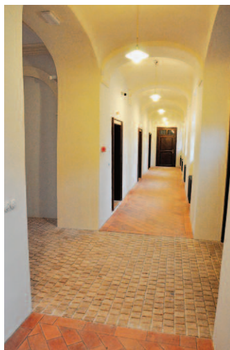
Obr. 11, 12: Přízemí zámku, stav po opravě (foto Jan Dohnal, 2015). Obr. 11: Původní dlažba v prostoru hl. schodiště zůstala zachována. Okolní cihelné zdivo bylo proti vztlínání injektováno. Obr. 12: Pod novou dlažbou chodby je odvětrávaná vzduchová dutina v celé ploše.
