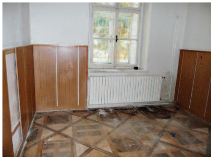
Obr. 8, 9: Interiér před zahájením rekonstrukce (2011). Obr. 8: Stav původních omítek v přízemí byl maskován novodobými úpravami. Obr. 9: Parkety a zdivo v patře pátého křídla poškozené zatékáním vlhkosti z venkovního kanálu.
