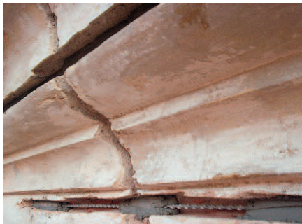
Obr. 9, 10: Praha, Černínský palác, 2013. Vlevo: Stehování prasklé římsy nerezovými pruty vlepenými do drážek. Vpravo: Injektáž prasklého kladí epoxidem.
