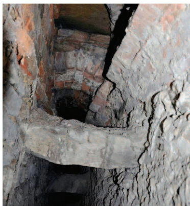
Obr. 5, 6: Páté křídlo odděluje od terénu obvodový kanál krytý kamennými žlabovkami a větráný do soklu. Klenba kanálu byla zřícená, zdevastována vlhkostí a mrazem.
