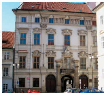
Obr. 7, 8: Praha, Hartigovský palác. Vlevo: „Tradiční“ úprava z 80. let (rezné kameny, barvené štuky). Vpravo: Úprava z r. 2004, repliky stříkaných omítek, vápenné nátěry i na tmelených kamenných prvcích.
