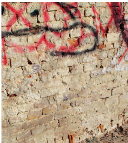
Obr. 7: Zdivo oranžerie injektované polyuretanovou pryskyřicí (stav 2011).
