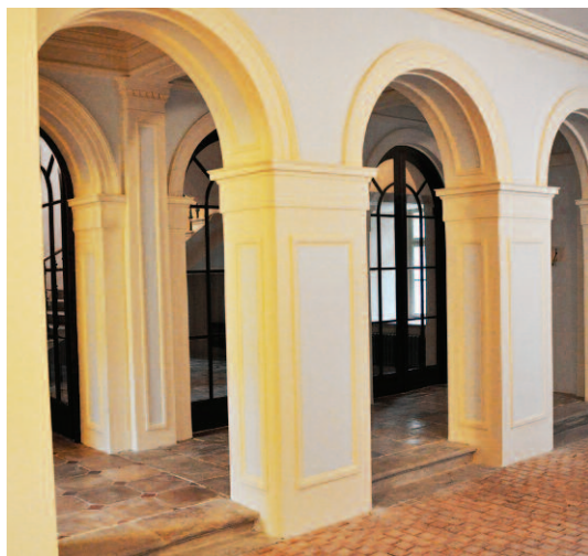
Obr. 11, 12: Přízemí zámku, stav po opravě (foto Jan Dohnal, 2015). Obr. 11: Původní dlažba v prostoru hl. schodiště zůstala zachována. Okolní cihelné zdivo bylo proti vztlínání injektováno. Obr. 12: Pod novou dlažbou chodby je odvětrávaná vzduchová dutina v celé ploše.
