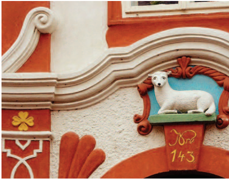
Obr. 3: Zdařile provedená barevnost umocňuje architekturu fasády, zdůrazňuje její proporce i důležité detaily. Vedle pečlivé volby vhodných odstínů barev má zásadní význam správné provedení rozvrhu barev, technologie provedení, struktura a příprava podkladu.
