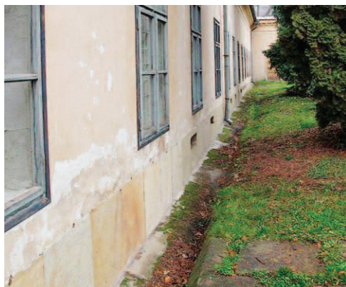
Obr. 5, 6: Páté křídlo odděluje od terénu obvodový kanál krytý kamennými žlabovkami a větráný do soklu. Klenba kanálu byla zřícená, zdevastována vlhkostí a mrazem.
