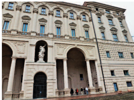
Obr. 17, 18: Praha, Černínský palác. Vlevo: Úprava z konce 80. let respektovala odhalené kamenné povrchy dle arch. P. Janáka. Vpravo: Nová úprava z r. 2012 zcelila výraz fasády (omítnuté resp. natřené kamenné prvky).
