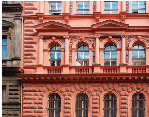
Obr. 8: I při správném rozčlenění fasád může zdárný výsledek zkazit nepřilíš zásadní posun barevného tónu. Častým problémem jsou odstíny červenohnědé, zemité, „cihelné“, terakotové atp. Většina barevných vzorníků nabízí spíše různé růžové či nařinavé barvy, které jsou vzdálené původním předlohám.
