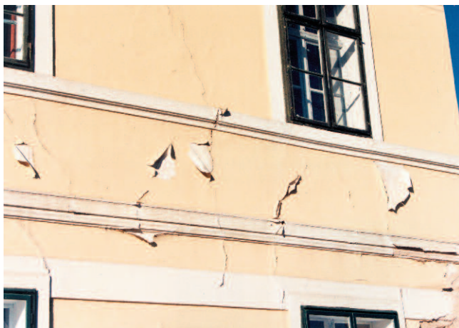
Obr. 1: Vzhled, vlastnosti i způsob stárnutí jsou pro každý materiál charakteristické.
