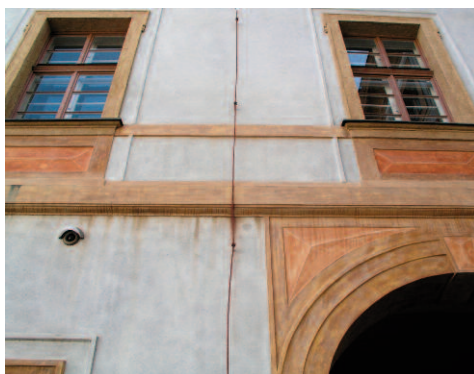
Obr. 3, 4: Praha, Toskánský palác. Vlevo: Oprava z pol. 80. let řešila (dle průzkumu z poč. 80. let) dvorní průčelí v kombinaci bílo-červené. Vpravo: Oprava z r. 1998 dle důkladného sondážního průzkumu vč. mikroskop. snímků (Tradice – Z. Poláková, M. Pavala) prováděného v průběhu realizace změnila řešení na probarvenou omítku a natírané články. Snaha o užití tradiční technologie při fixaci barev vedla k smývárání krátce po provedení, stav se však posléze ustálil.
