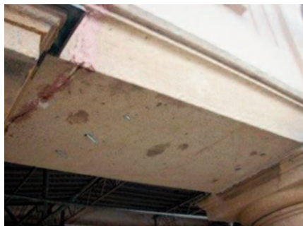
Obr. 9, 10: Praha, Černínský palác, 2013. Vlevo: Stehování prasklé římsy nerezovými pruty vlepenými do drážek. Vpravo: Injektáž prasklého kladí epoxidem.
