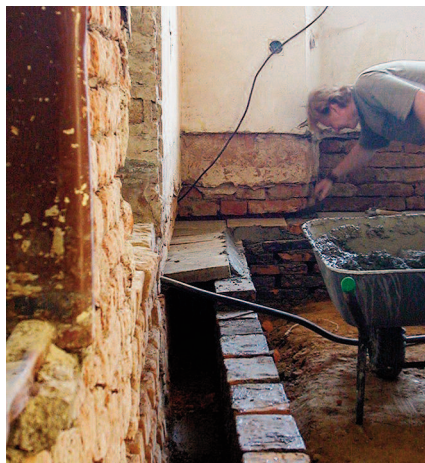
Obr. 5: Větrací kanály cca 200/300 mm byly částečně vyzděny ze starší cihelné dlažby máčené v asfaltu, jež byla nalezena pod podlahami.
