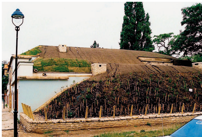
Obr. 3: Zemní těleso brány po provedení první jílové izolace – r. 2001.
