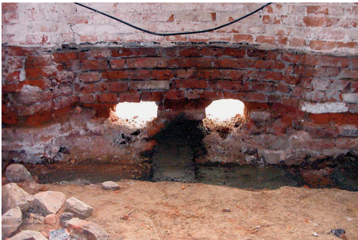
Obr. 6: Vytváření nádechových otvorů. V místě nádechů je kanál stavebně rozdělen do samostatných větví s odtahem do komína. V horní části obrázku je dobře patrná asfaltová izolace ze 60. let 20. stol.
