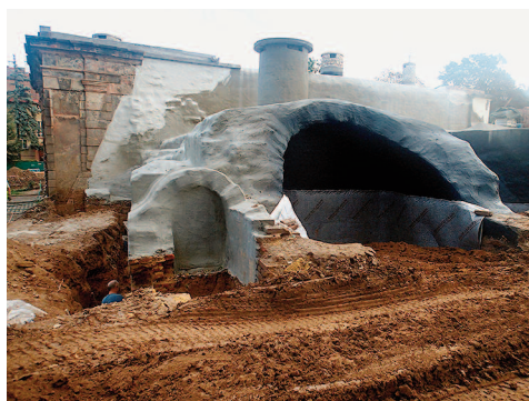
Obr. 5: Pro izolaci brány byl zvolen systém minerálních a bitumenových stěrek. Po odtěžení zeminy bylo zdivo očištěno a povrch nejprve zatřen maltou z hydraulického vápna. Teprve posléze byly stříkány stěrky – r. 2014.
