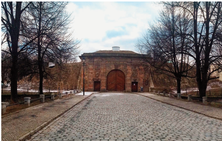
Obr. 6: Brána po obnově a zvýšení zemního tělesa – 02/2015.
